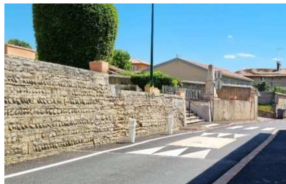
Traversée du centre avec vue sur le mur aux galets apparents
